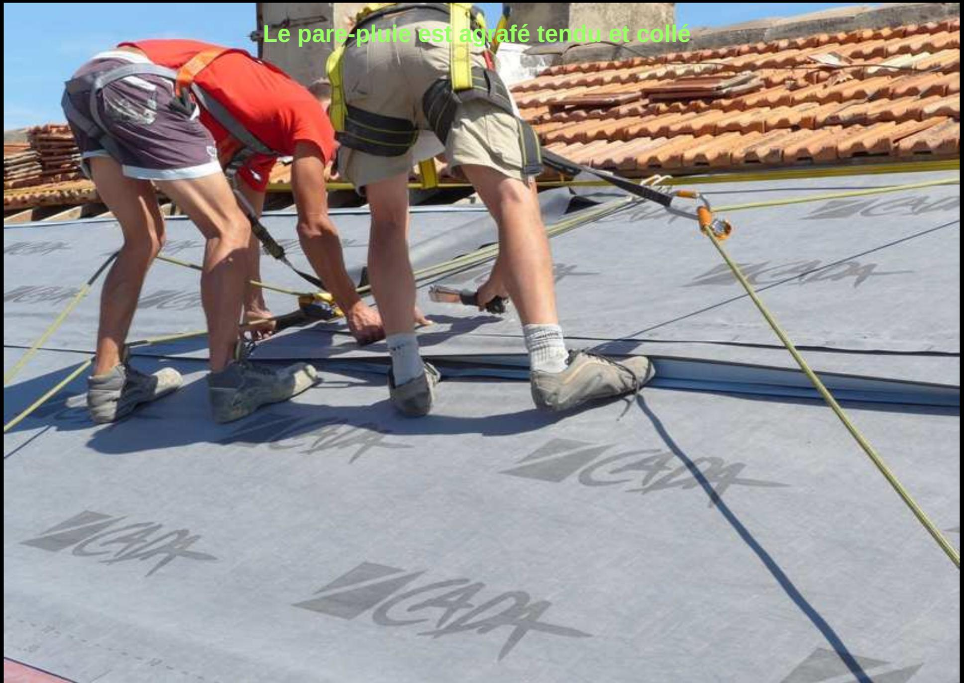
Le pare-pluie posé, les câbles de branchement des modules sont amenés sur le toit
