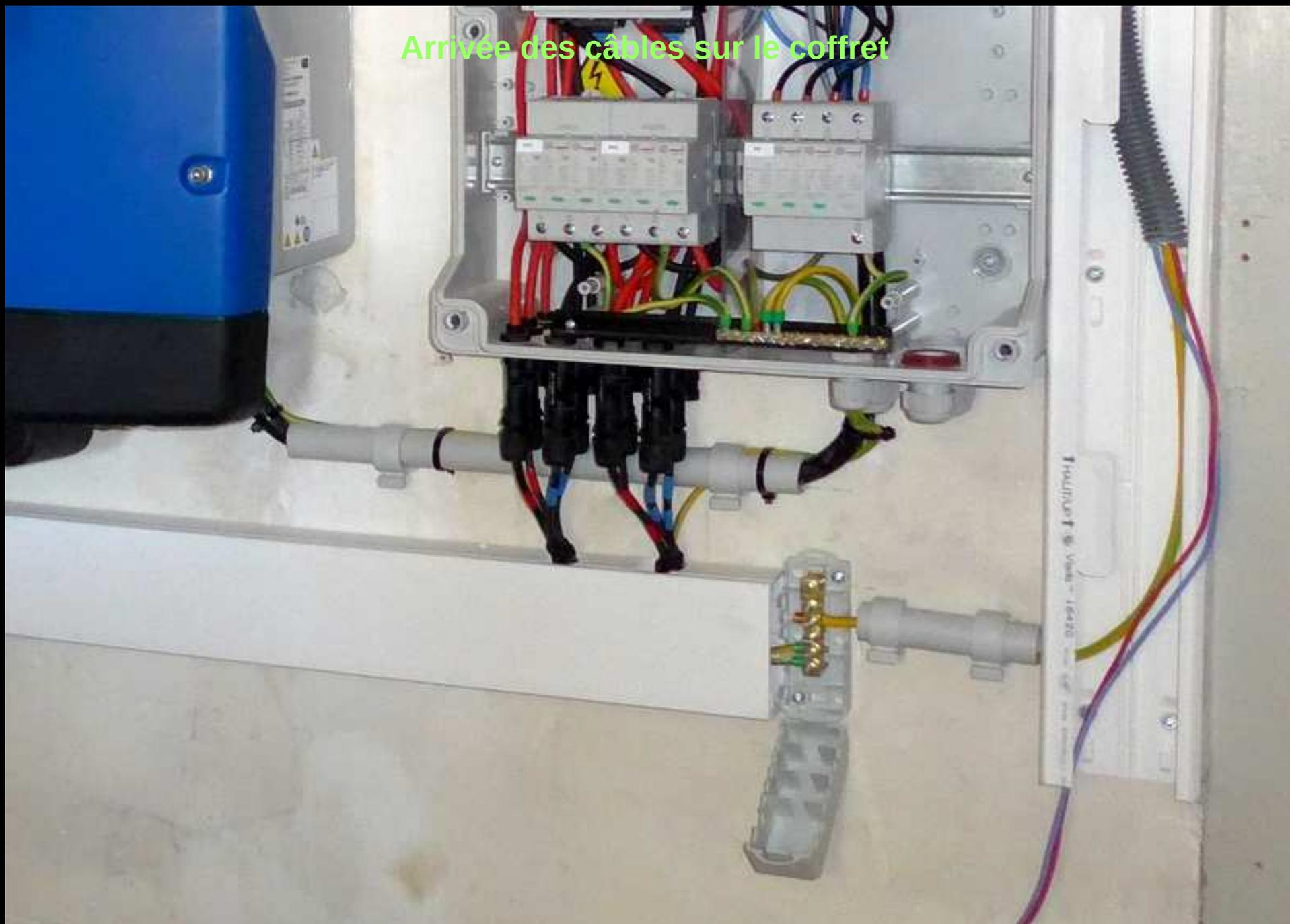
L'onduleur, le coffret de raccordement et l'appareil de suivi de la production
