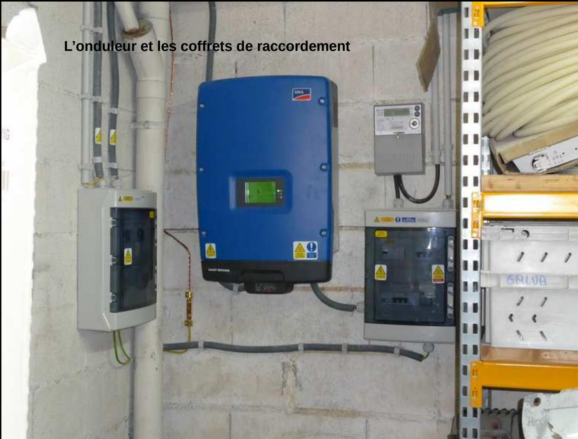
Passage du câble AC vers le raccordement EdF
