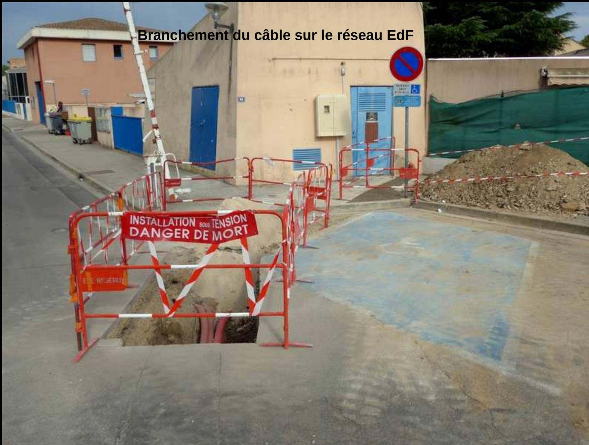
Raccordement sous tension
