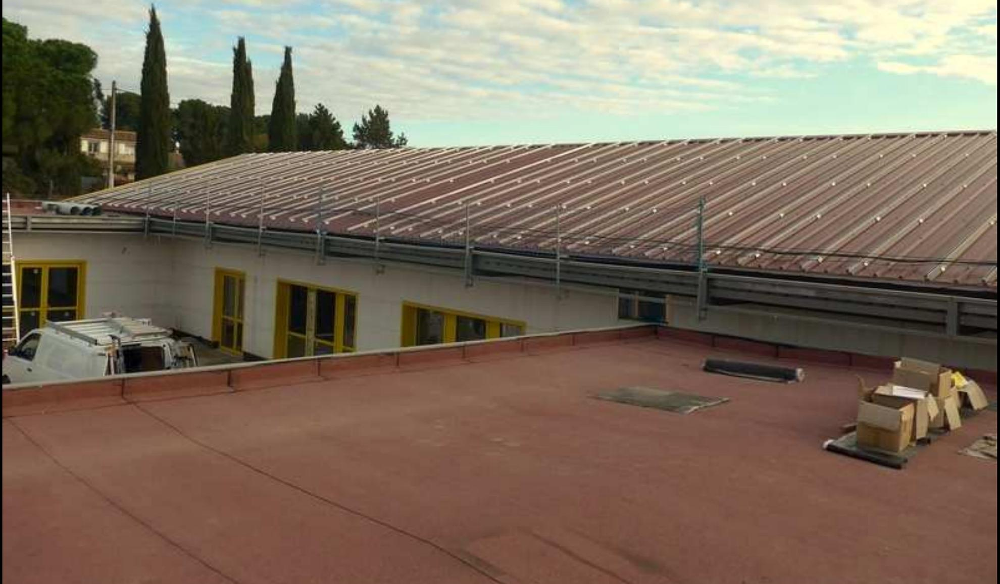
**Les câbles sous les modules sont tirés jusqu'à l'onduleur**
